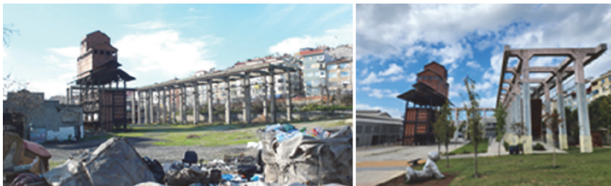
Slika 9. Hasanpaşa Gasworks prije (lijevo) i nakon (desno) obnove [62]
